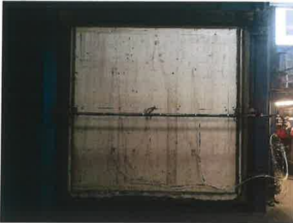
Bild 1: Ansicht der eingesetzten Massivholzkonstruktion von der feuerabgewandten Wandseite A.
