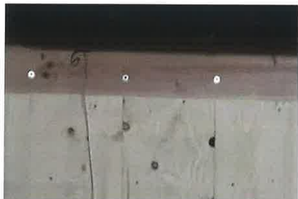
Bild 4: Ansicht des Laschenbrettes an der Oberseite der feuerabgewandten Wandseite A.
