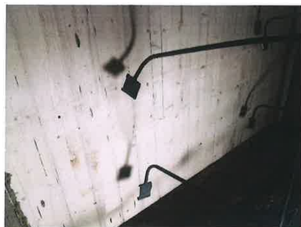
Bild 6: Blick auf die feuerzugewandte Wandseite B vor dem Start der Feuerwiderstandsprüfung.
