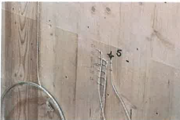
Bild 3: Exemplarische Detailansicht der in den verschiedenen Messebenen eingebrachten Thermoelemente im Bereich der Position 5 auf der feuerabgewandten Wandseite A.
