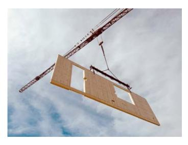
Die Woodbloc-Massivholzwände sind durch und durch aus massivem Holz. Sie kommen schon fertig auf die Baustelle, inklusive der Auslässe für Fenster und Türen. Foto: Ebner/Woodbloc
